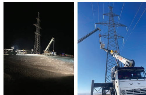
Шинээр тулгуур босгох ажлын явц
